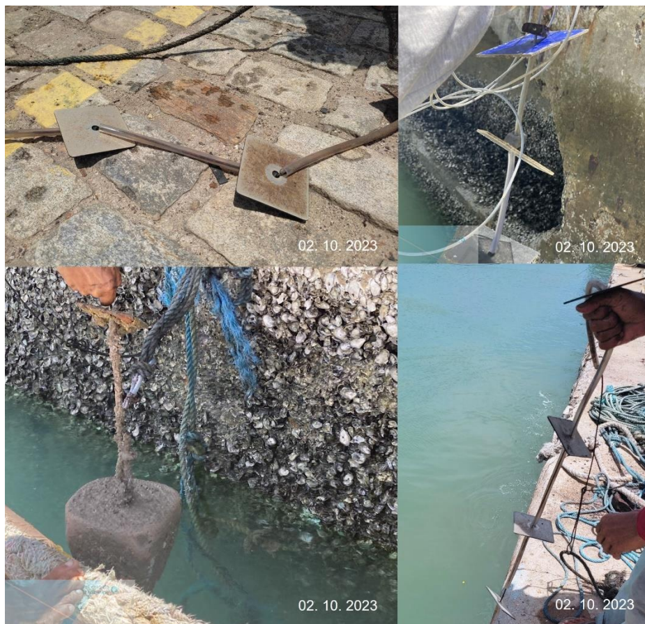
Figura 2 – Confeção e instalação das placas em outubro/2023 no Porto de Fortaleza/CE
